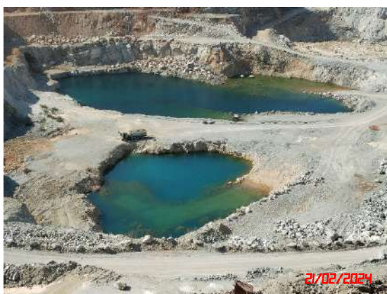
รูปที่ 19 บ่อรองรับน้ำ (Sump)
